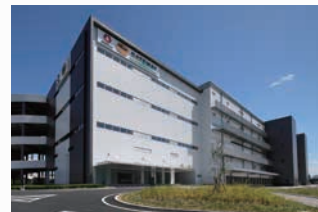
関西ロジスティックスセンター
